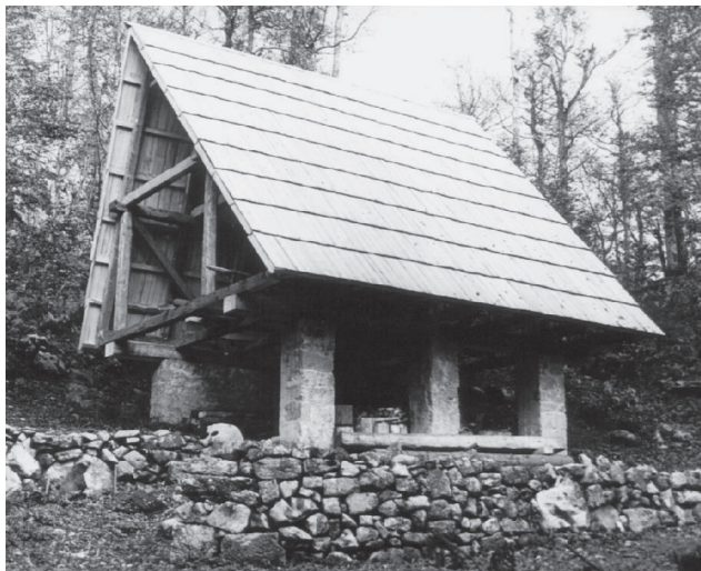
Bijele stijene - Kuća 1967. god. - Izgradnja
